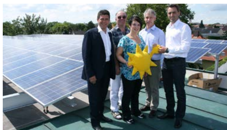
In Tulln entstehen die größten Photovoltaikflächen Österreichs, die von einer Gemeinde finanziert, errichtet und betrieben werden.
